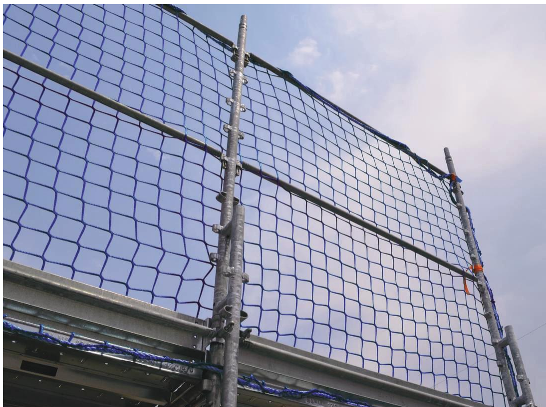
dettaglio anello di aggancio installato
